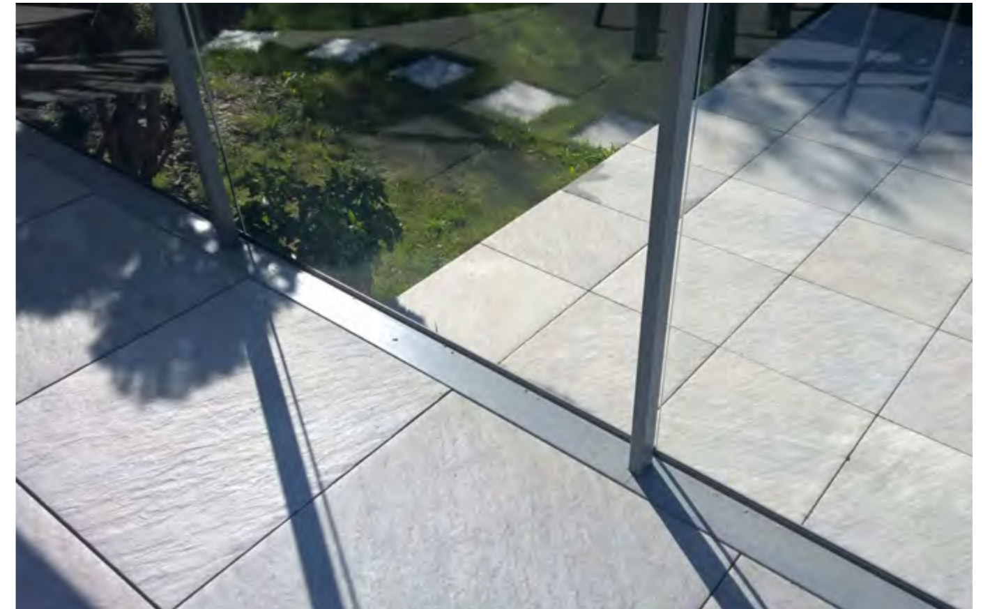
VUE INTÉRIEURE : Profil de raccordement au plancher
