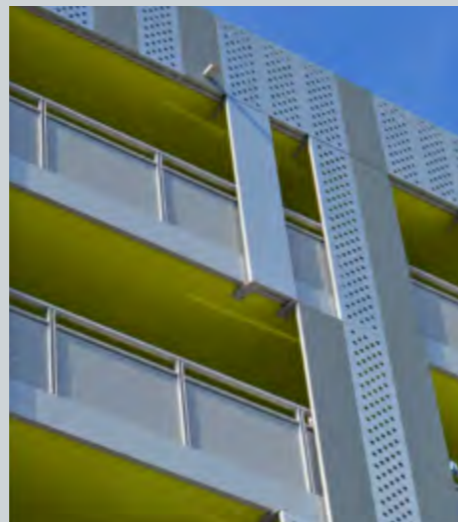
Garde-corps OXYTAL à remplissage tôle perforée avec montants ajourés et vide sous main-courante
