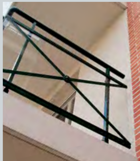
Garde-corps ÉMERAUDE à remplissage clair avec vide sous main-courante et croix de Saint-André
