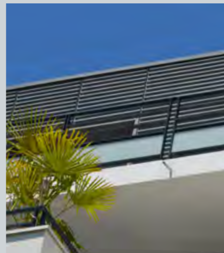
Garde-corps OXYTAL à remplissage opale avec montants ajourés et 2 lisses intermédiaires
