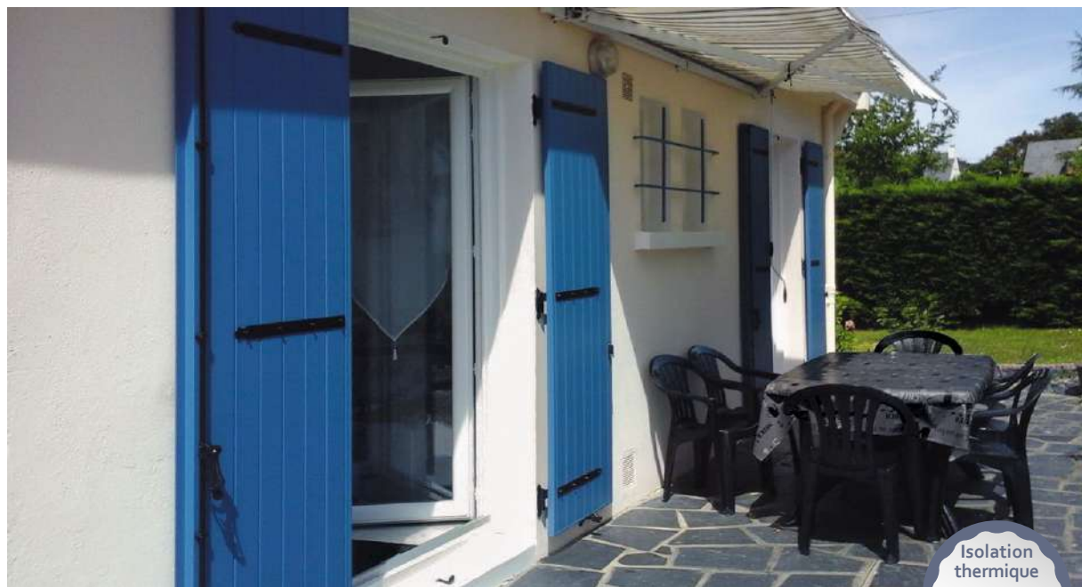
Lames verticales 28 mm teintées dans la masse ou plaxées.
