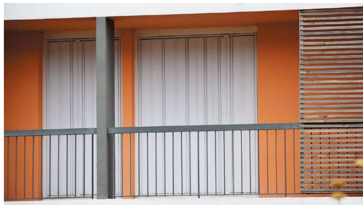
Panneaux composés de vantaux pvc alvéolaire de 14 mm d'épaisseur, cadre aluminium. Fermeture assurée par un verrou tendeur en aluminium.
